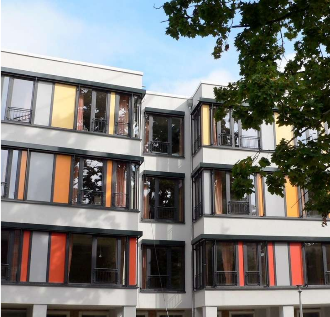
Abbildung: Ansicht Ostflügel DRK - Krankenhaus Clementinenhaus
